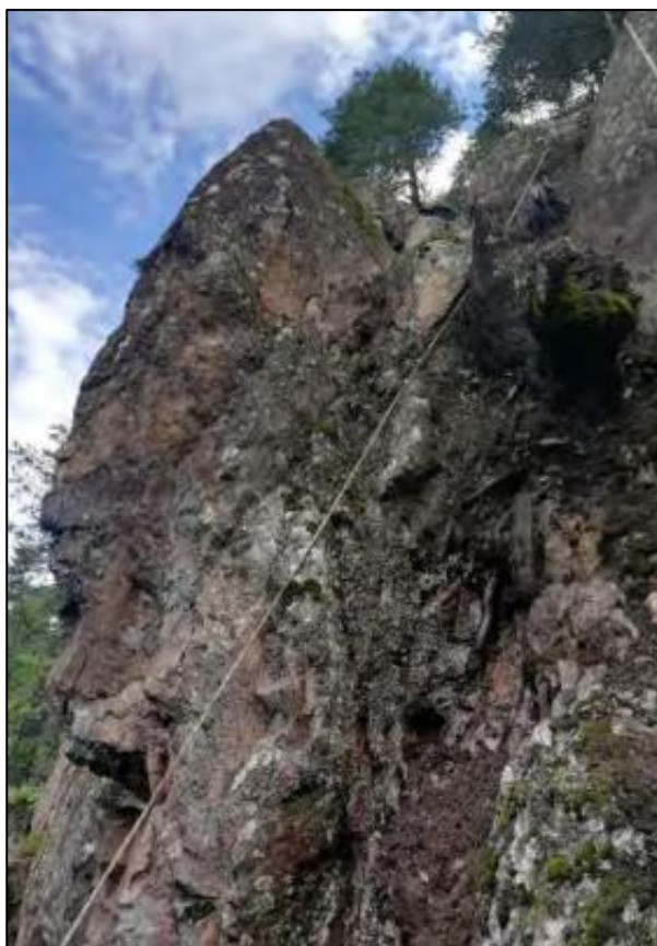
Foto 7.2 – diedro potenzialmente instabile oggetto di consolidamento – cfr. Part. 4a
