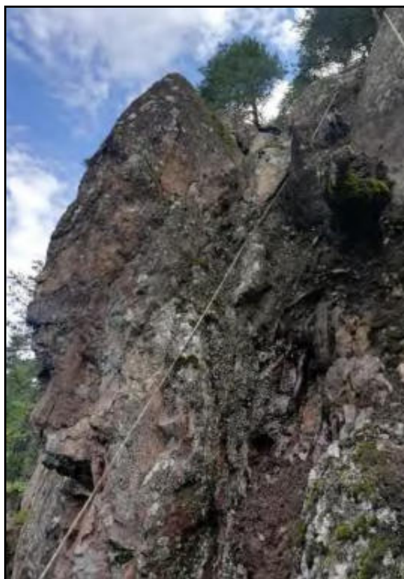
Figura 18. Diedro potenzialmente instabile oggetto di consolidamento (Zambotti e Zanon, 2021).
